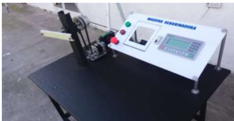
Figura 28: Instalación de tablero de control. Elaboración propia. (2019).
