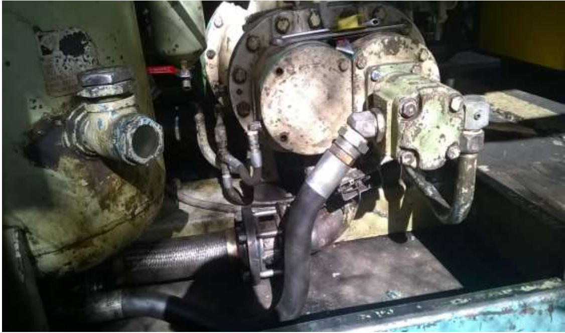
Figura 30: Vista frontal de los elementos hidráulicos instalados. Fuente propia (2018)
