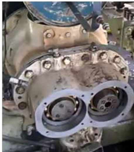
Figura 23: Colocación de la tapa lateral. Fuente propia (2018)
