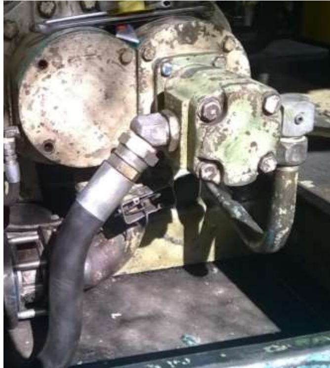
Figura 27: Mangueras hidráulicas de la bomba. Fuente propia (2018)
