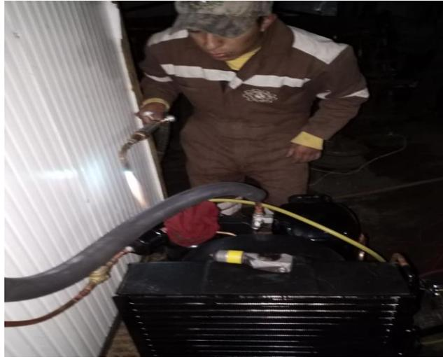
*Nota.* La figura demuestra la corrección de fugas existente en el sistema de refrigeración.
