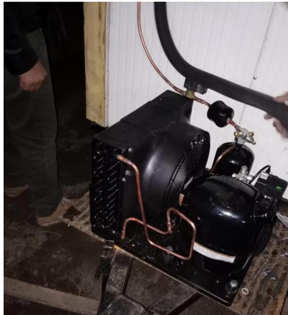
*Nota.* Ensamblaje del sistema de refrigeración.
