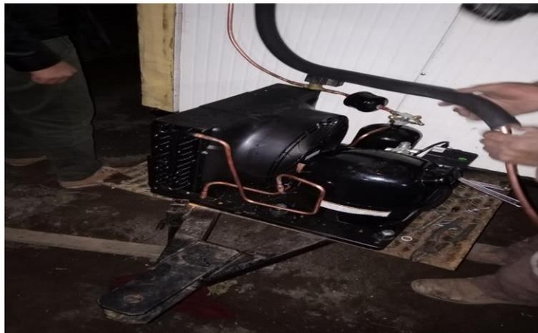
*Nota.* La figura demuestra el ensamblaje de sistema de refrigeración con la unidad condensadora.
