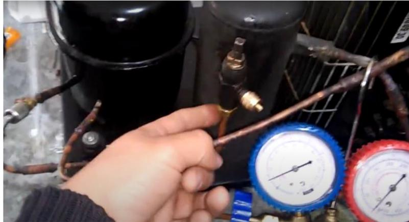
*Nota.* Carga de refrigerante con nanómetros.**Esquema eléctrico de la unidad condensadora**
