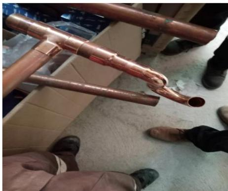
*Nota.* Colocación del acople en la tubería de cobre.
