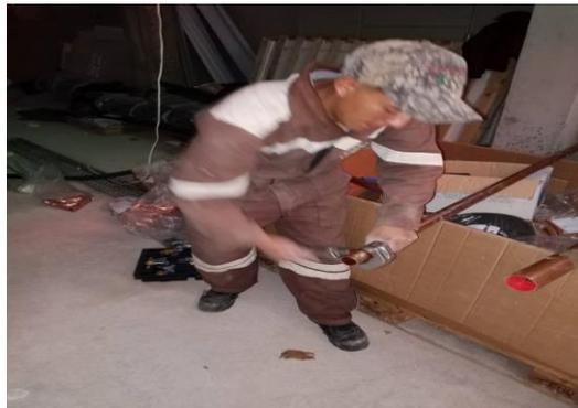
*Nota.* Corte de tubería de cobre con la cortadora de tubos.
