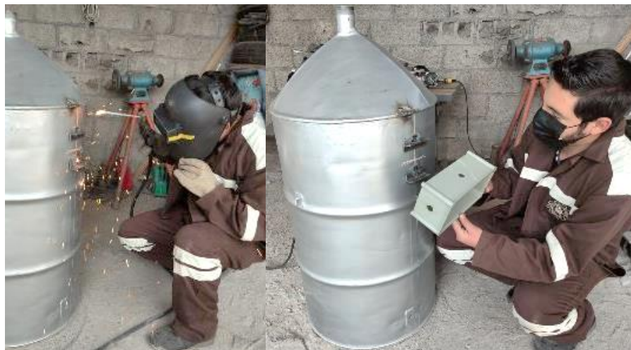
Imagen No. 22 Ubicación de la caja de distribución. Elaborado por: Paul Fernando Naranjo Torres Fuente: Propia.
