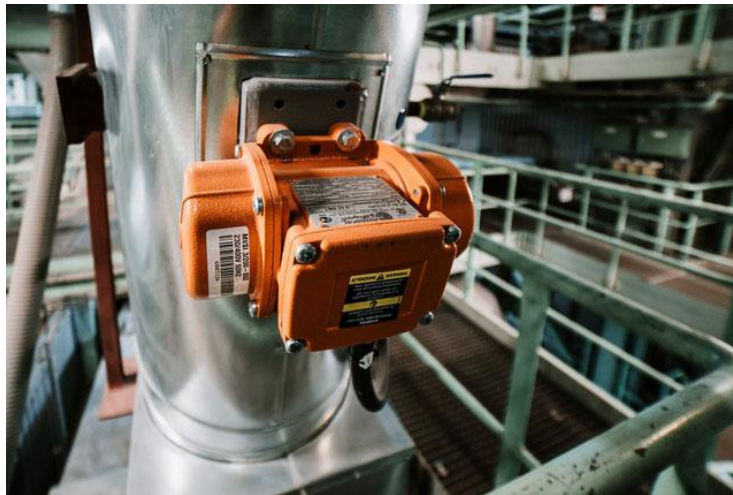
Imagen No. 7 Motovibradores eléctricos Elaborado por: Distrimotor Fuente: https://www.distrimotor.es/
