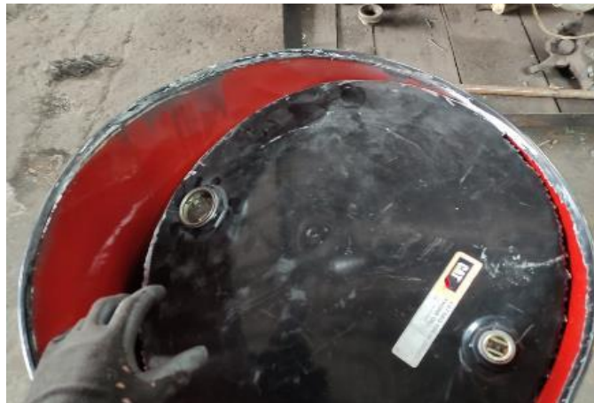
Imagen No. 13 Corte de la tapa superior del tanque. Elaborado por: Paul Fernando Naranjo Torres Fuente: Propia.
