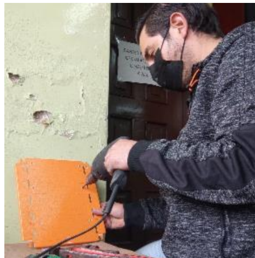
Imagen No. 35 Perforaciones en la base del tablero. Elaborado por: Paul Fernando Naranjo Torres Fuente: Propia.
