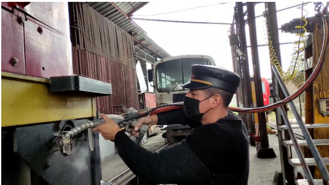
Anexo No. 17 Nivelación de arena en los depósitos inferiores lado derecho Elaborado por: Paul Fernando Naranjo Torres Fuente: Propia
