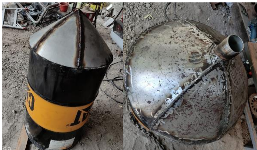
Imagen No. 15 Cono cuadrangular del tanque de almacenamiento. Elaborado por: Paul Fernando Naranjo Torres Fuente: Propia.
