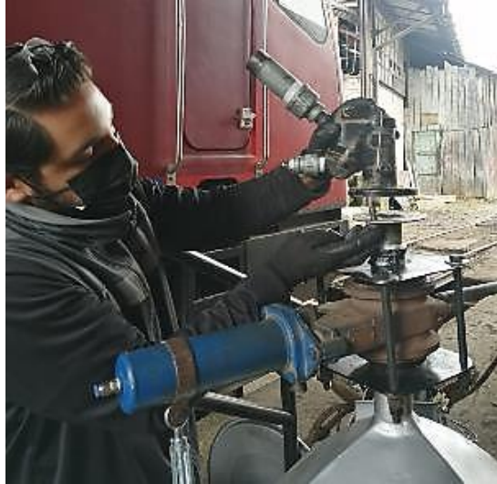
Imagen No. 27 Acoplamiento del soplador neumático. Elaborado por: Paul Fernando Naranjo Torres Fuente: Propia.
