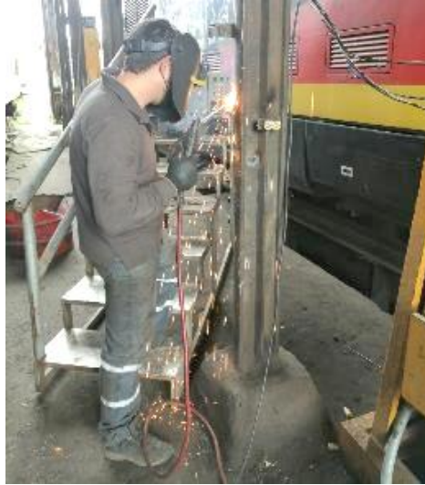
Imagen No. 39 Soldadura de las bases de fijación del tablero de control. Elaborado por: Paul Fernando Naranjo Torres Fuente: Propia.
