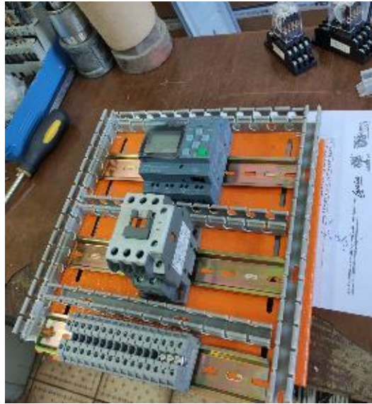
Imagen No. 36 Colocación de los elementos eléctricos. Elaborado por: Paul Fernando Naranjo Torres Fuente: Propia.
