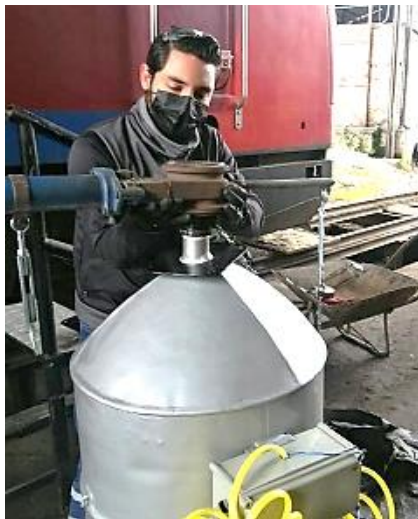
Imagen No. 24 Acoplamiento de la válvula tipo cuchilla. Elaborado por: Paul Fernando Naranjo Torres Fuente: Propia.
