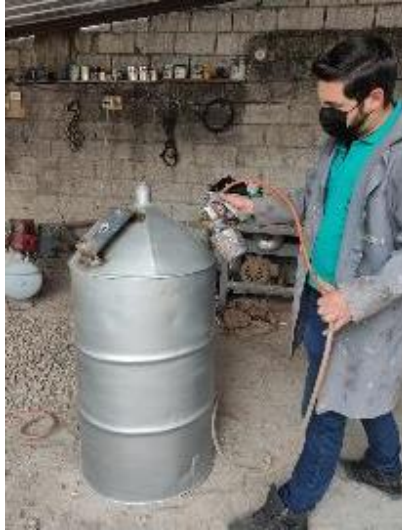
Imagen No. 18 Trabajo de pintura del depósito de almacenamiento. Elaborado por: Paul Fernando Naranjo Torres Fuente: Propia.
