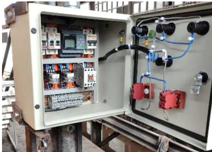
Imagen No. 40 Montaje del Tablero de control. Elaborado por: Paul Fernando Naranjo Torres Fuente: Propia.
