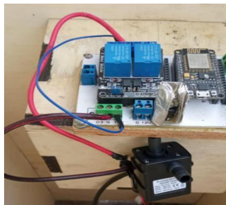
Imagen No. 43 Conexión de bomba de agua Elaborado por: Anthony Richard Gualotuña Rey Fuente: Datos de la investigación
