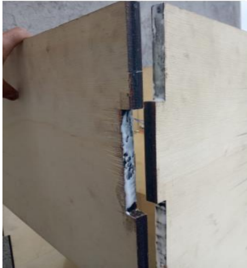
Imagen No. 38 Aplicación del pegamento goma Elaborado por: Anthony Richard Gualotuña Rey Fuente: Datos de la investigación
