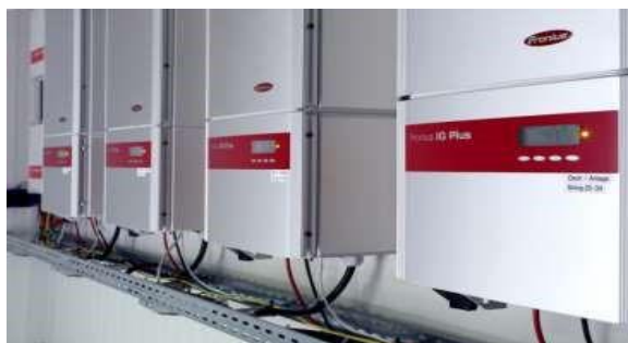
Imagen N° 10 Inversor de Red Elaborado por: Leonardo Romero Fuente: Aguirre P, (2011)
