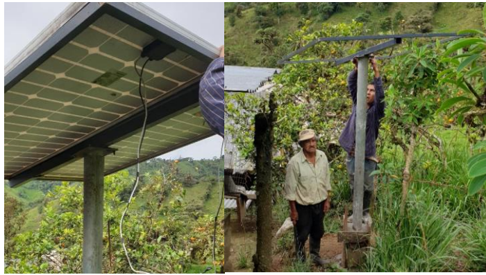
Imagen N° 24 Montaje de paneles Policristalinos
