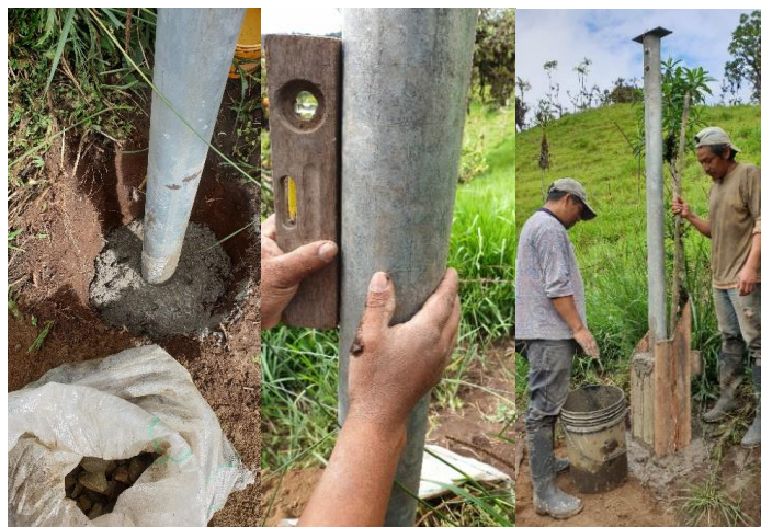
Imagen N° 23 Montaje del tubo con hormigón
