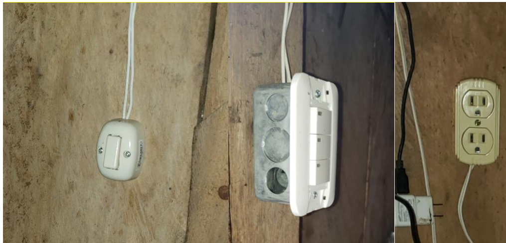
Imagen N° 28 Puesta de tomacorrientes y boquillas.
