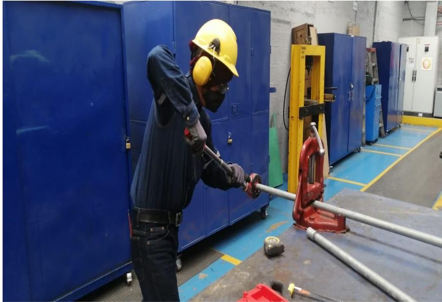
**Imagen No. 45** Corte y fabricación de rosca de la tubería rígida de  $\frac{1}{2}$  in
