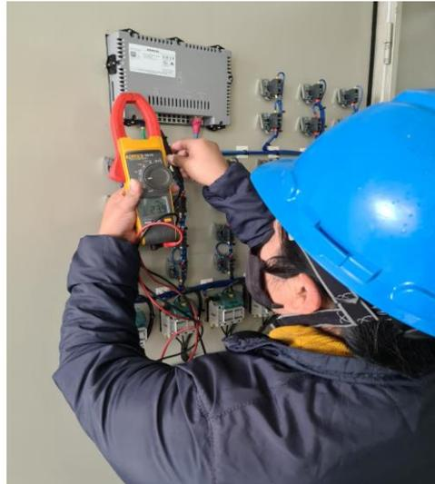
**Imagen No. 36** Medición de voltaje del HMI
