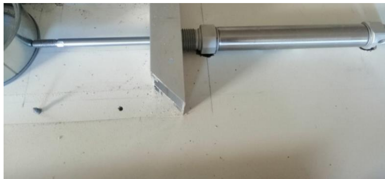
Figura 37: Perforación para cilindros
