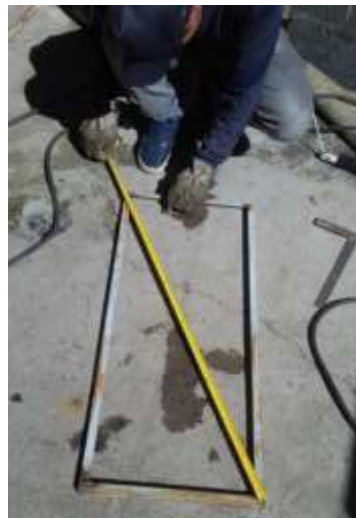
Figura 16: Medición de base y corte 0.89cm x 0.37cm. Elaboración propia, (2019).
