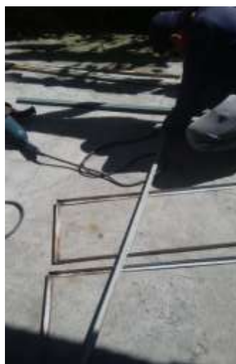
Figura 17: Construcción de las bases horizontales. Elaboración propia, (2019).
