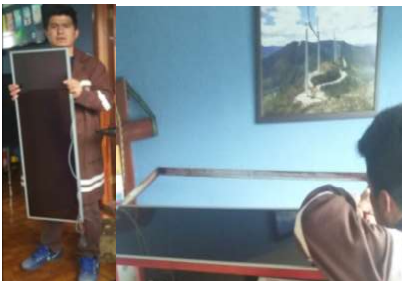
Figura 20: Montaje de paneles fotovoltaico sobre la estructura. Elaboración propia, (2019).
