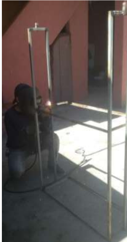
Figura 18: Construcción de las bases horizontales. Elaboración propia, (2019).
