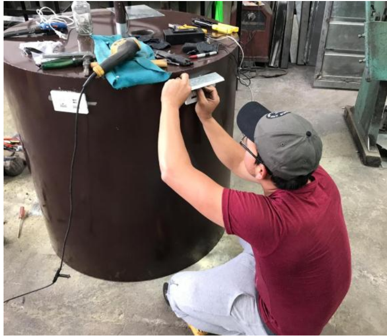
Figura 20: Instalación de los tomacorrientes parte posterior Elaboración propia, (2019)
