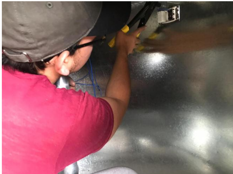
Figura 19: Instalación de los tomacorrientes parte interior Elaboración propia, (2019)
