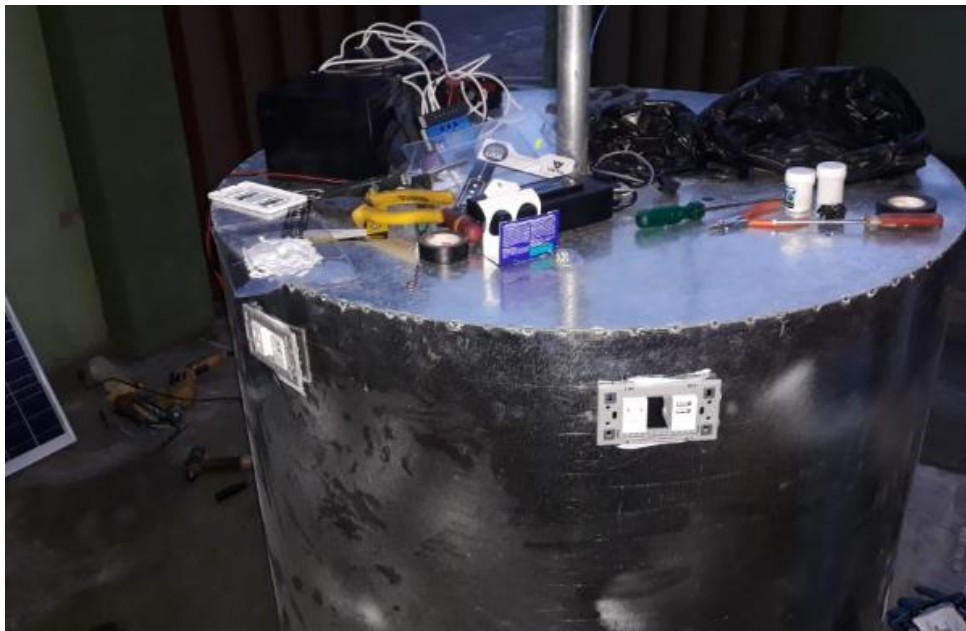
Figura 21: Instalación de los tomacorrientes (Elaboración propia, 2019)
