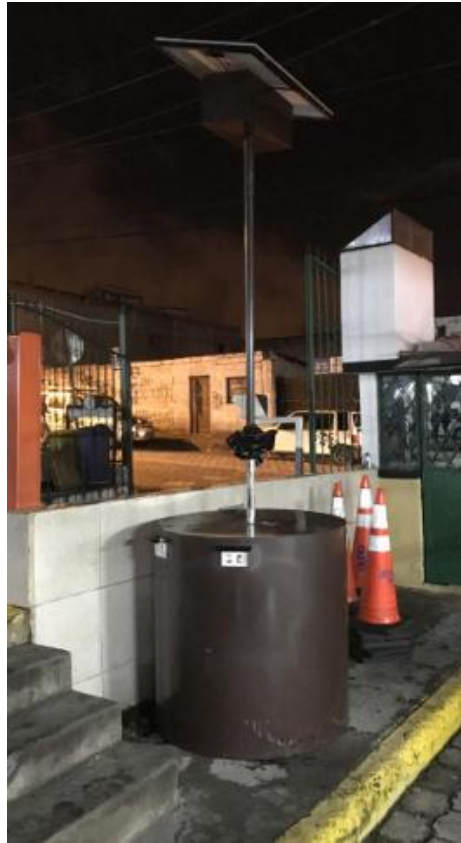
Figura 22: Sistema instalado en el Instituto Tecnológico Vida Nueva (Elaboración propia, 2019)
