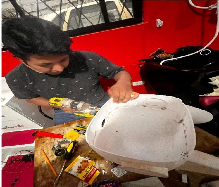
*Nota.* Se perfora la estructura para ubicar la placa principal para el control de los motores, elaboración propia.
