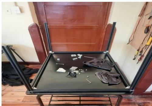
*Nota.* En la siguiente imagen se puede visualizar como se colocaron los soportes para la base superior.
