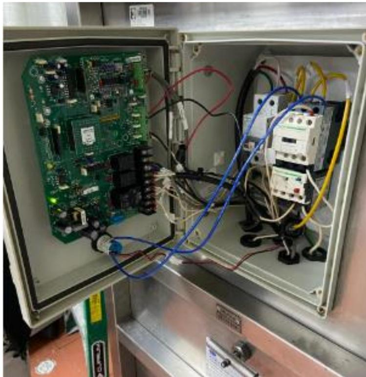
*Nota.* En la imagen se muestra el tablero de control de ósmosis inversa.
