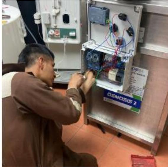
*Nota.* Sobre la caja plástica se colocan los contactores que en la imagen se están conectando para el cambio de transferencia de ciclo de la primera bomba, lo cual permitirá que en la etapa de trabajo funcionen independientemente.
