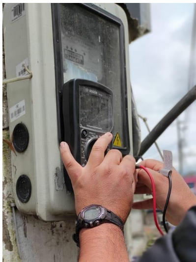
Imagen No. 42 Medición de Líneas de Voltaje
