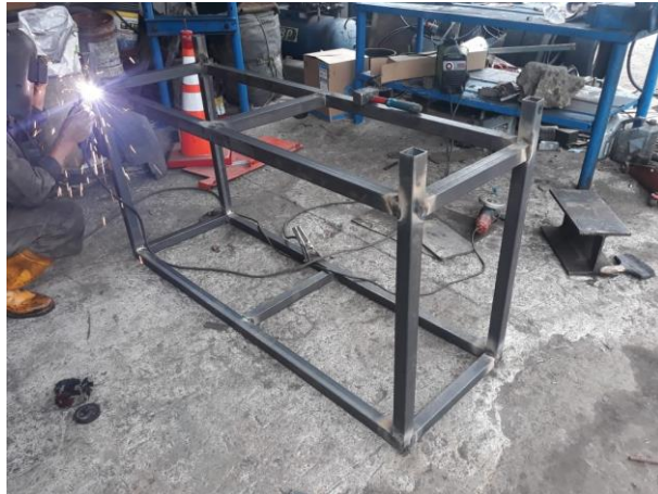
Imagen No. 17 Estructura de soporte de la prensa
