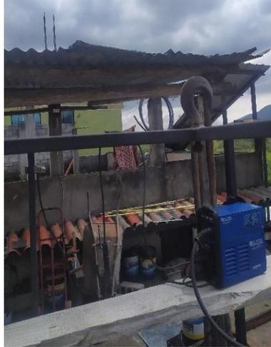
*Nota.* Este gráfico muestra el gancho soporte para la jaula equivalente a 500 kg de resistencia.
