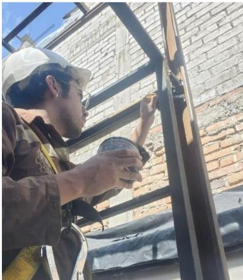
*Nota.* En esta fotografía se procedió a engrasar cada base de la estructura con el fin de reducir la fricción entre los dos metales y lubricar la correa G y los rodamientos de la jaula.
