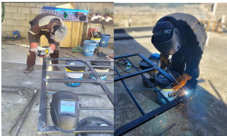
*Nota.* Estas fotografías representan la fabricación de las bases y techo de la estructura tipo jaula.
