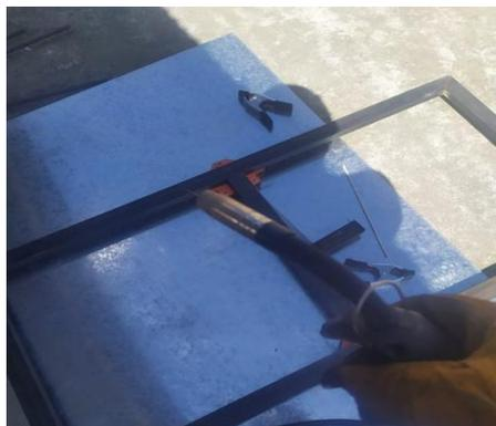
*Nota.* Esta imagen representa la fabricación de las bases y techo de la estructura tipo jaula.
