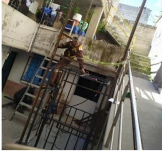
*Nota.* En esta fotografía se muestra la colocación de los soportes secundarios estructurales.
