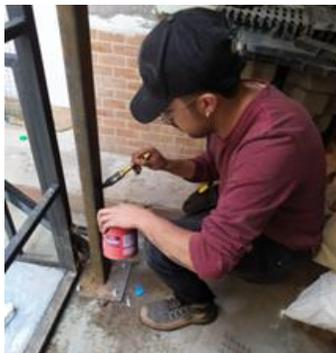
*Nota.* En esta fotografía se muestra los últimos detalles que se estaba añadiendo al proyecto, concluyendo con la pintura de los soportes de las columnas del elevador eléctrico.
