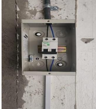
*Nota.* En esta fotografía se muestra el breaker instalado en su respectivo cuadro eléctrico.
