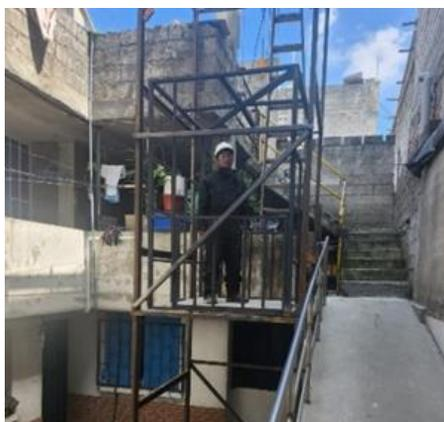
*Nota.* En la fotografía se muestra la primera prueba de funcionamiento de la plataforma que tiene como fin que no hubiera rozos entre las bases y la jaula.
