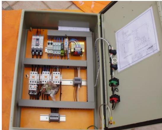
*Nota.* Representación de un tablero eléctrico. Reproducido de Tableros Eléctricos, por Wattco, 2019 (<https://www.inav.cl/tableros-electricos/>).
