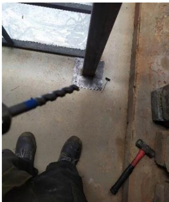
*Nota.* En esta imagen se muestra el uso de broca de  $\frac{1}{2}$  x 6 in para perforaciones de anclaje.
