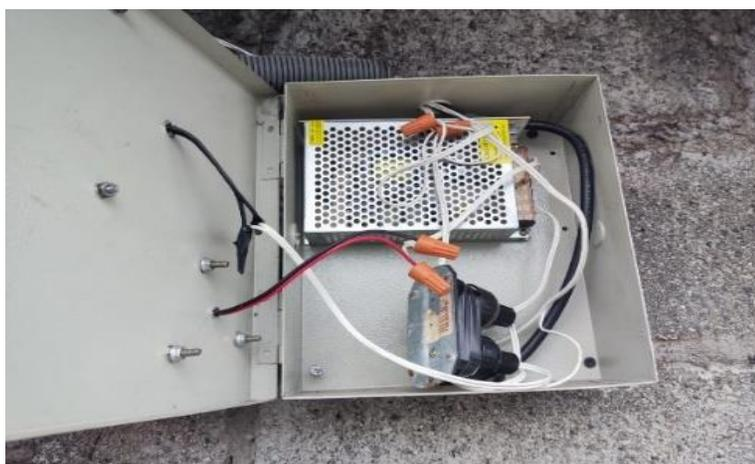
**Nota.** Se muestra la caja de protección cuando no se encontraba la conexión con el interruptor inteligente y no hay reacondicionamiento de los cables.
