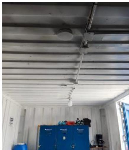
*Nota.* Se observa el detector de humo colocado en la sección de lockers.
