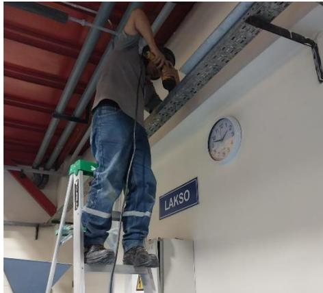
*Nota.* Cableado y colocación de ductos para paso de cableado.
