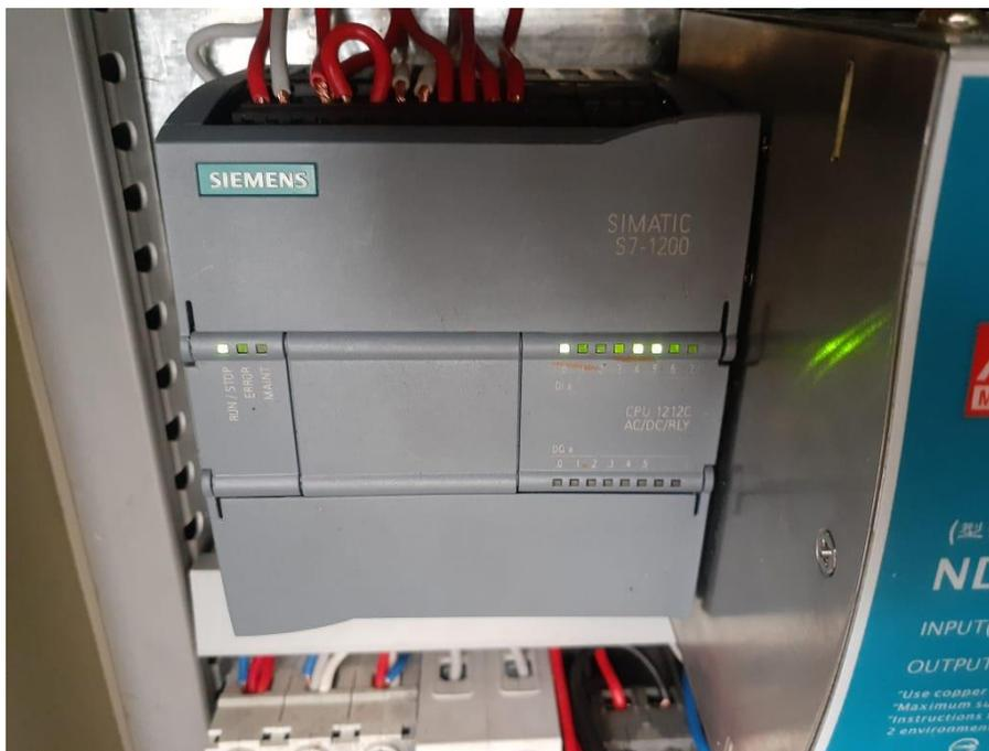
*Nota.* Se realizaron pruebas de señal con los sensores capacitivos que permitan la llegada a de señal a PLC S7 1200.
