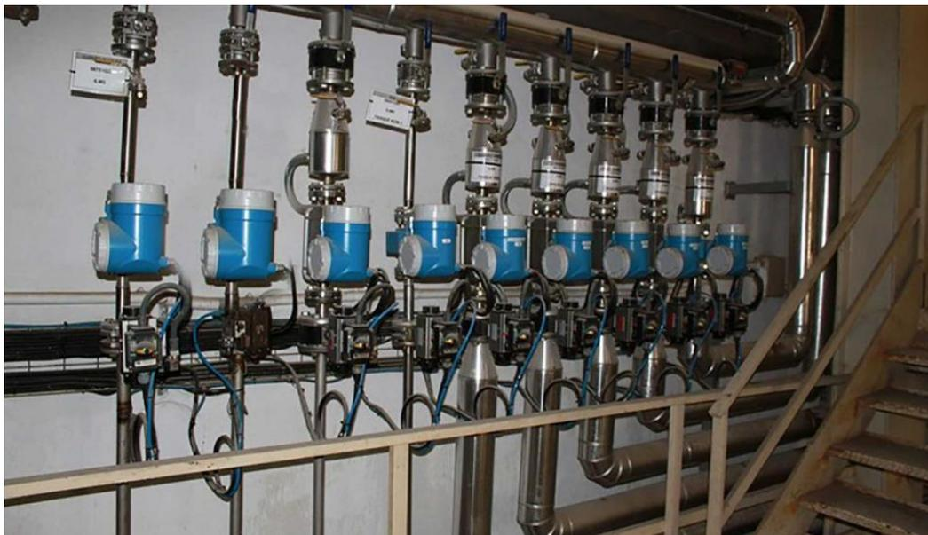
*Nota.* La figura muestra los sistemas de dosificación por caudalímetro. Tomado de Equipos y soluciones para la dosificación de líquidos, por S. Gimon, 2020.
