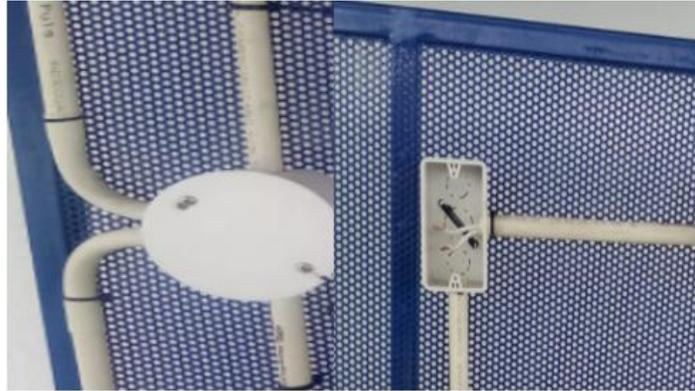
Nota. Instalaciones de tuberías y cajetines en la estructura metálica.
