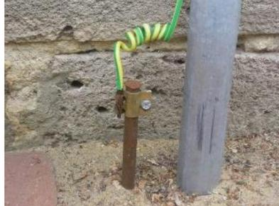
*Nota.* Elemento de cobre el cual sirve para desfogar la corriente por medio de la tierra y proteger equipos conectados al tablero de distribución. Tomado de (enel-codesa, 2021)
