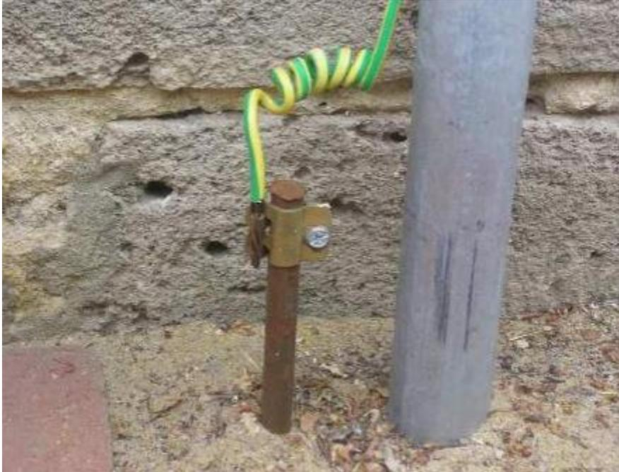
Nota. La figura muestra la conexión de la puesta a tierra.
