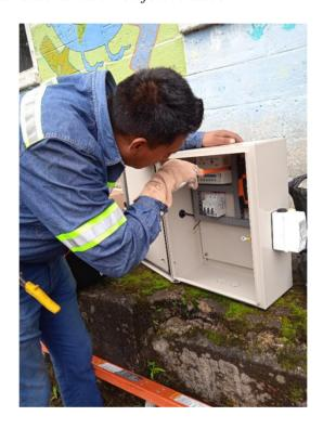
*Nota*. Se procede a realizar el armado de los componentes dentro del gabinete (2022).
