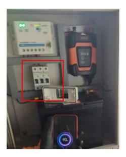
*Nota*. La figura muestra el conjunto de accionadores instalados como protección del sistema fotovoltaico (2022).
