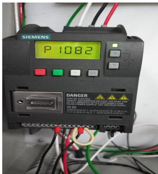
**Figura 27.** Modificación de la frecuencia en el variador del tambor
