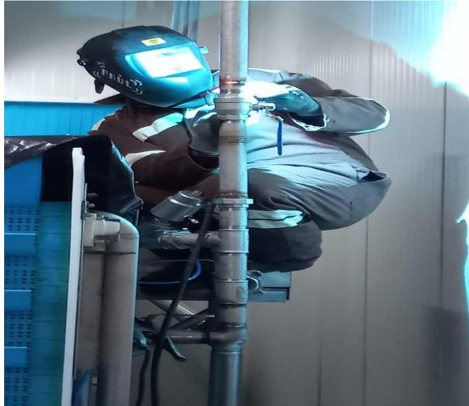
**Figura 21.** Instalación de las tuberías de agua para abastecimiento de la cuba.
