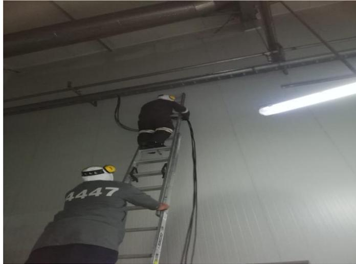
**Figura 16.** Tendido eléctrico neumático para alimentar a la cuba de lavado.
