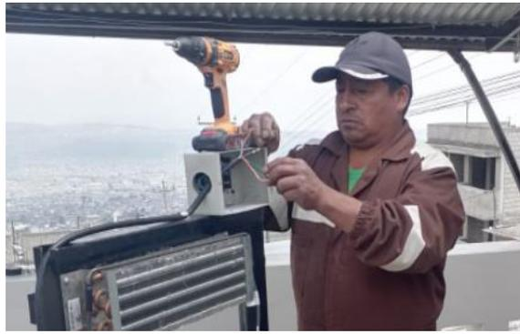
**Imagen No. 31** Conexión de cables para la fuente de 220 voltios
