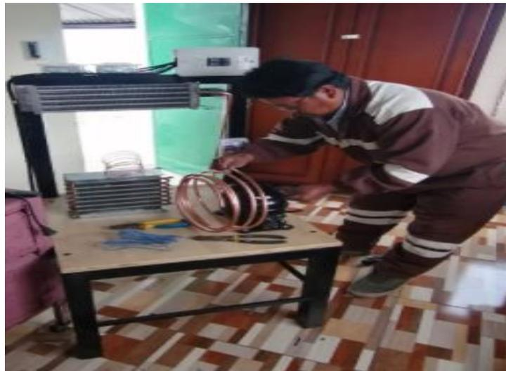
**Imagen No. 32** Figurando las cañerías para cada sistema
