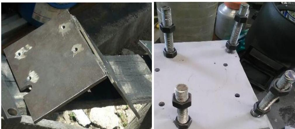
Imagen No. 31 Perforación de las placas y colocación de espárragos
