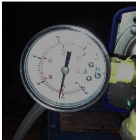
*Figura 20.* Manómetro utilizado para medición de presión adecuada del sistema.
