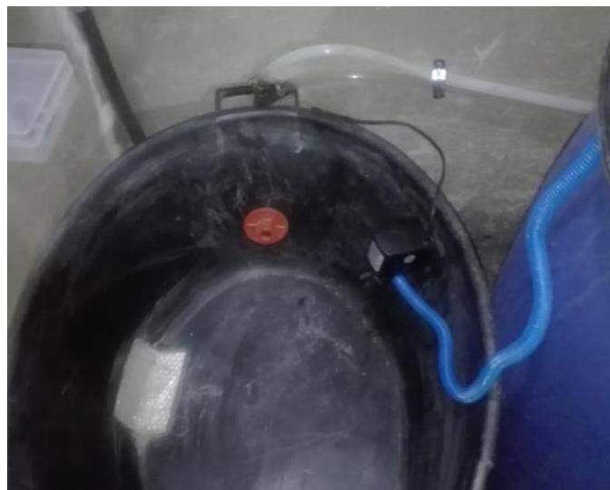
*Figura 39.* Implementación de la bomba de agua auxiliar para circulación de agua.
