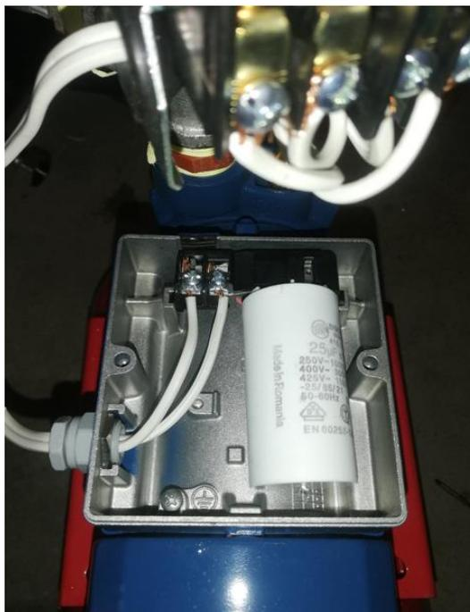
*Figura 36.* Instalación eléctrica del sistema hidroneumático.
