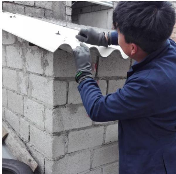
Figura 29. Construcción de la estructura del sistema de captación de agua pluvial.
