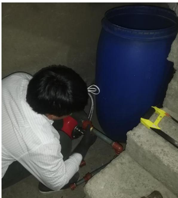
*Figura 37.* Implementación del sistema hidroneumático con tanques de almacenamiento de agua.
