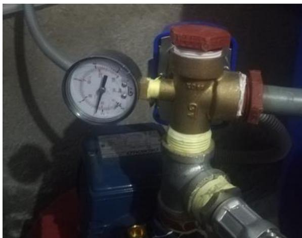
*Figura 55. Presión del sistema hidroneumático 2º medición*
