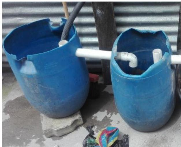
*Figura 31. Armado de captación y filtro de agua residual.*
