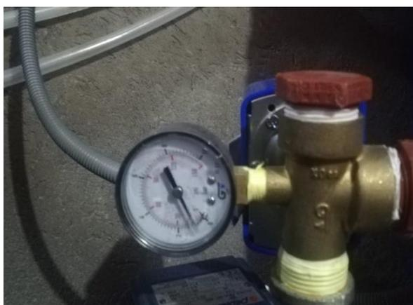
*Figura 56. Presión del sistema hidroneumático 3º medición*
