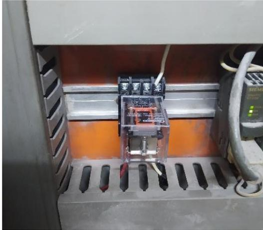
**Imagen 50.** Relay Camsco 24 VDC
