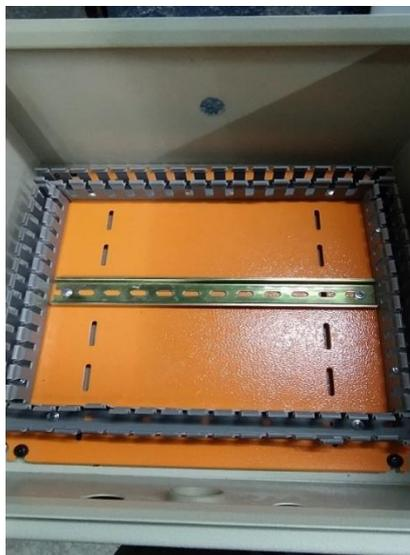
**Imagen 35.** Colocación riel din y canaletas
