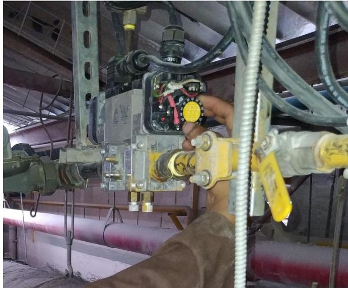
**Imagen 60.** Presostato de baja presión
