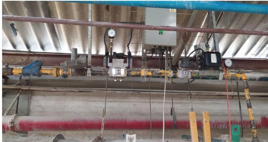
**Imagen 43.** Montaje del nuevo tren de válvulas
