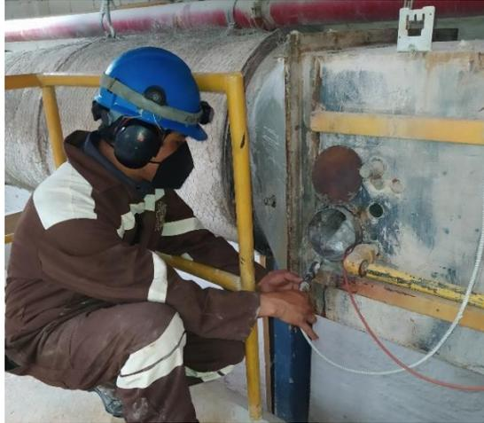
**Imagen 68.** Desconexión de sensor de flama
