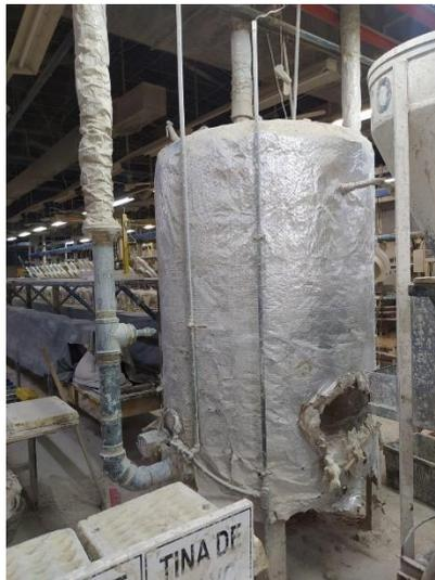
**Imagen 49.** Depósito de agua caliente
