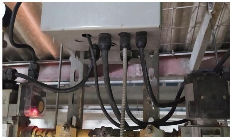
**Imagen 45.** Conexión del tablero controlador de flama
