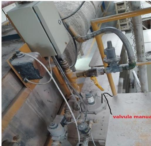
**Imagen 24.** Válvula de paso de combustible
