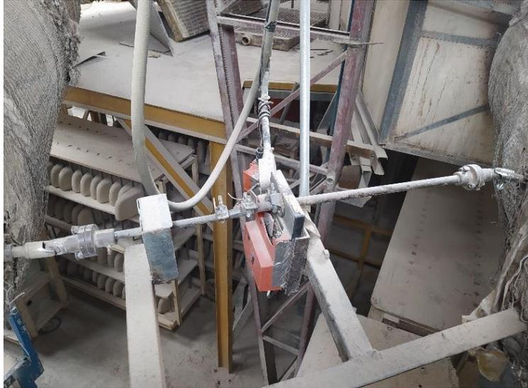
**Imagen 26.** Acoplamiento de actuador SM24-SR a compuerta
