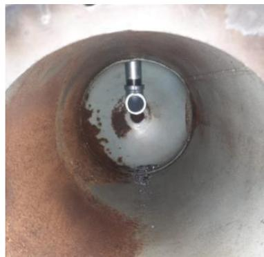
**Imagen No. 28** Adecuación de tubería para ensamblaje del filtro
