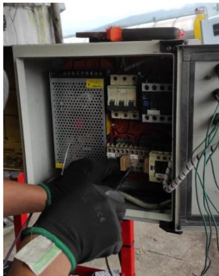
**Imagen No. 44** Instalación del circuito de fuerza
