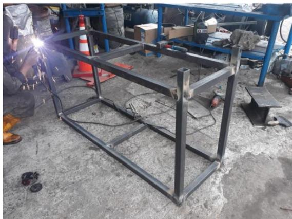
**Imagen No. 26** proceso de soldadura
