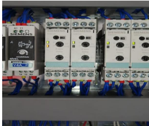
Imagen No. 20 Supervisor de nivel Elaborado por: Marco Santiago Mendoza Casa Fuente: Datos de la investigación
