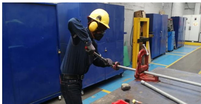
Imagen No. 17 Elaboración de tubería eléctrica
