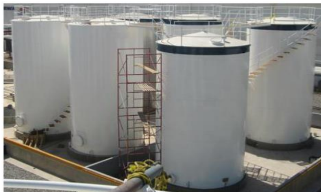
Imagen No. 2 Tanque cilíndrico vertical de techo fijo Elaborado por: García (2020) Fuente: Datos de la investigación
