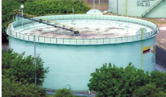
Imagen No. 3 Tanque cilíndrico vertical de techo flotante
